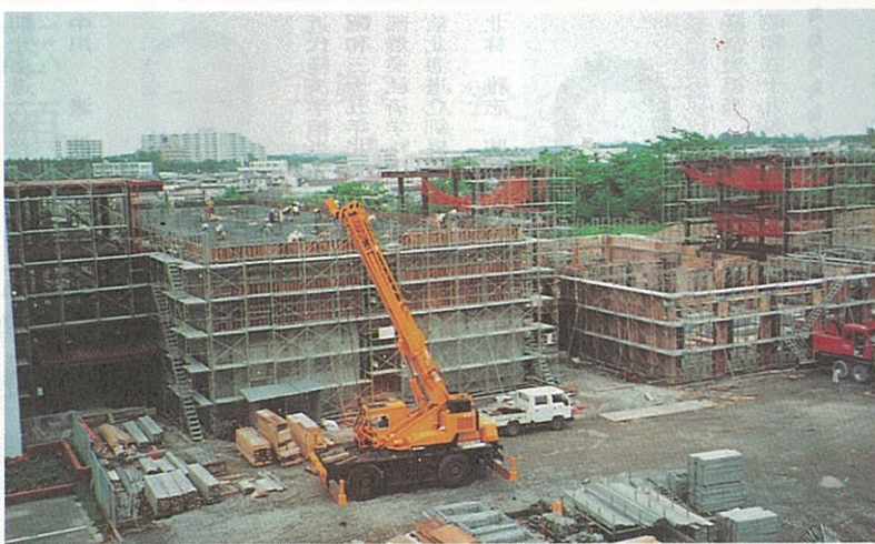
順調に工事の進むC館・D館
