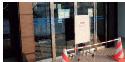
建物入口を限定したため閉鎖しているA館入口
